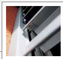
Chaque lame est fixée individuellement sur le côté
